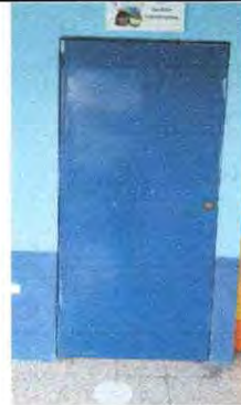
Foto 2: Mantenimiento a estructura (lijado, cambio de tubo, cepillado, sujeciones, aplicación de pintura)
