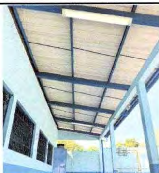
Foto 23 : Sustitución de lamparas tipo led
