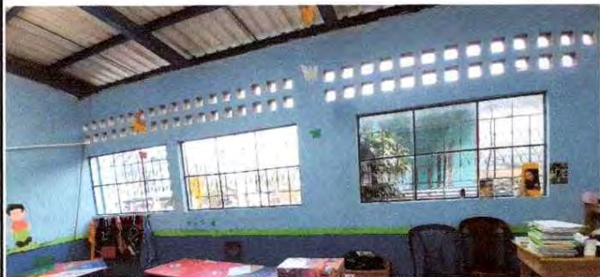
Foto 7: Sustitución de ventanas de metal por pvc
