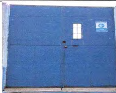
Foto 6: Sustitución de portón de metal
