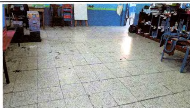
Foto 16 : Sustitución de piso ceramico
