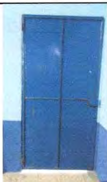
Foto 3: Mantenimiento a estructura (lijado, cambio de tubo, cepillado, sujeciones, aplicación de pintura)
