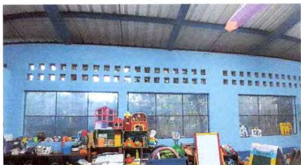
Foto 9 : Sustitución de ventanas de metal por pvc
