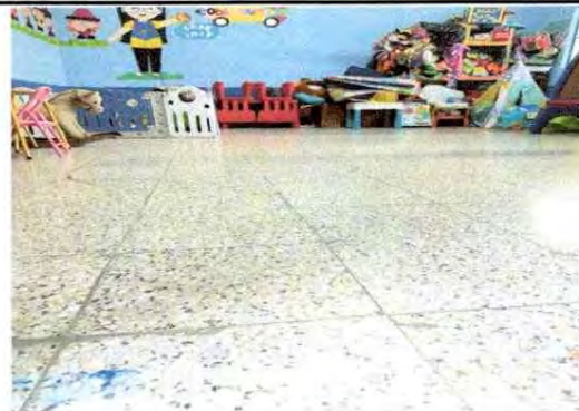
Foto 14 : Sustitución de piso ceramico
