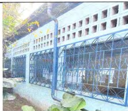
Foto 12 : Mantenimiento de balcones de metal
