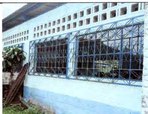
Foto 10 : Mantenimiento de balcones de metal
