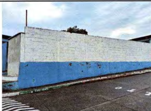
Foto 19 : Reparación de muro perimetral de block con tubo Hg y malla galvanizada, soleras intermedias y columnas
