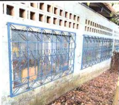
Foto 11 : Mantenimiento de balcones de metal
