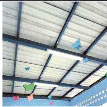
Foto 20 : Sustitución de lamparas tipo led
