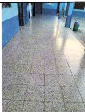
Foto 15 : Sustitución de piso ceramico
