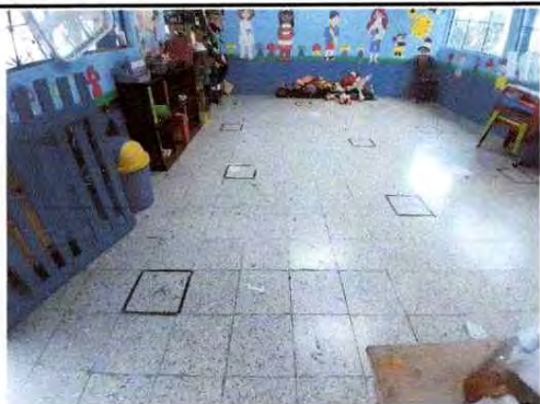
Foto 13 : Sustitución de piso ceramico
