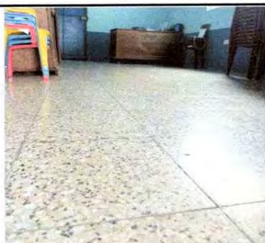
Foto 17 : Sustitución de piso ceramico
